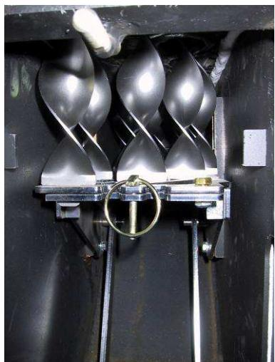
7. Vyjmout závlačku a 1 cm vytáhnout spodní plech (jisticí plech virbulátorů)
